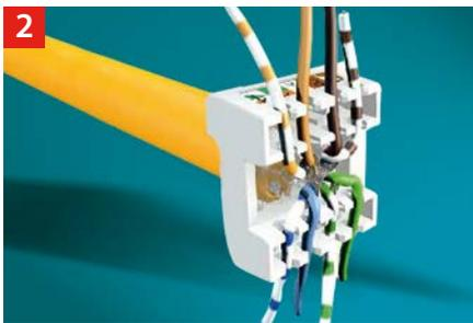
Die Adernpaare entsprechend dem gewählten Farbcode durch die Öffnung im Aufteiler stecken und so festziehen, dass das Kabel am Aufteiler endet.
