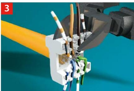
Die überstehenden Enden der Adern so dicht wie möglich am Aufteiler abschneiden.
