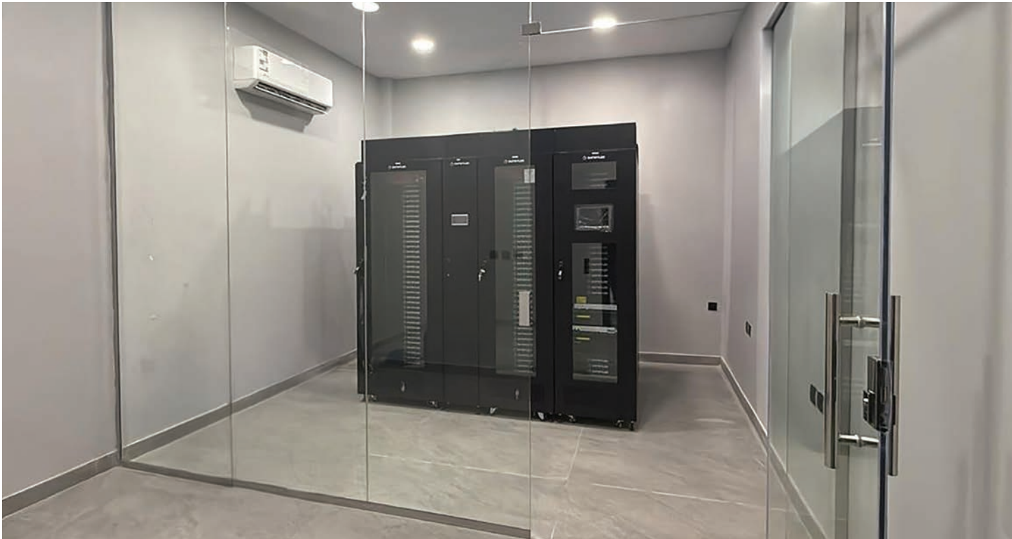
Al-Rawaf总部部署的智能模块化数据中心解决方案
