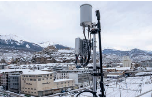
搭载5G微型射频单元的移动天线
