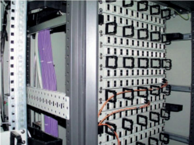
Die Optomod-LWL-Kabel und -Verteilerfelder im Verteilerraum der Forschungsstation
