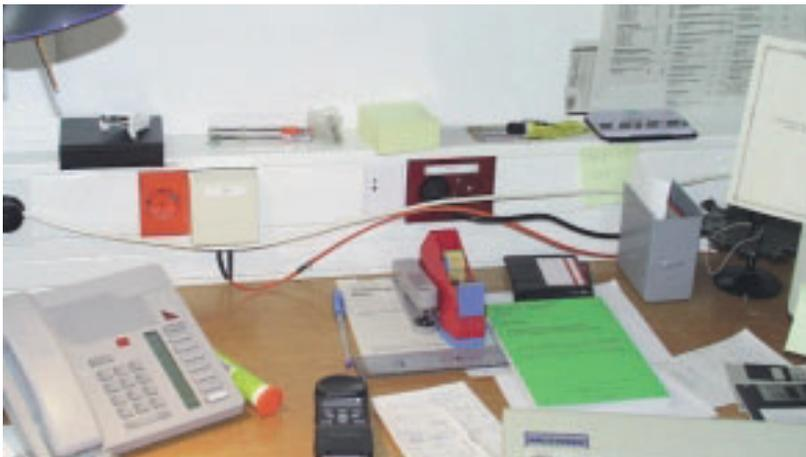
Alle Arbeitsplätze im Schneefernerhaus verfügen über LWL-Anschlüsse und Steckdosen mit Überspannungsschutz
