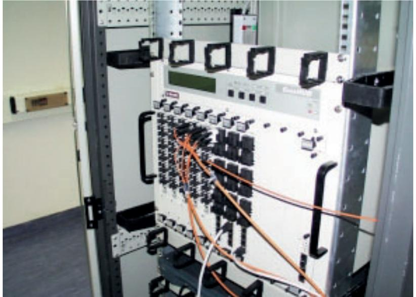
Die Anbindung an die aktiven Komponenten, in diesem Fall an einen Hub
